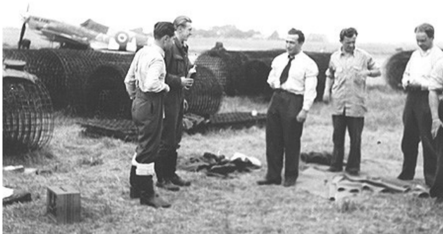
Pose des treillis métalliques.
